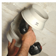
Przymocowanie wspornika
